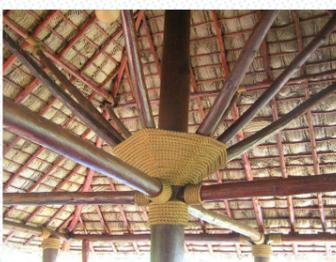
Faré - Charpente typiquement kanak pour soutenir les toitures des cases
